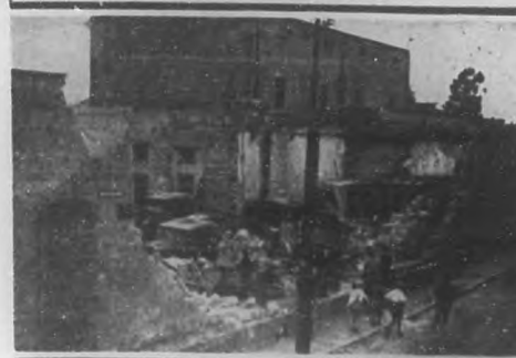
Derrumbe de la Calle de Soto en las afueras de Ciudad México
