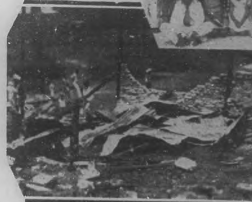
FUEGO EN SANTIAGO.—Esto fué cuanto quedó de la casa cita en Entramada y Pedroso, totalmente destruida por un violento incendio que se declaró a las doce de la noche.
